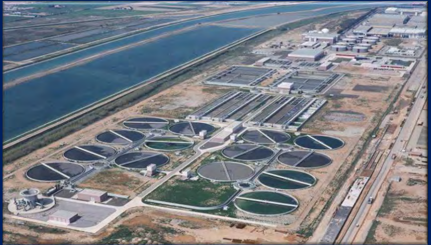
El Prat de Llobregat Wastewater Reuse Plant. Barcelona, Spain.
